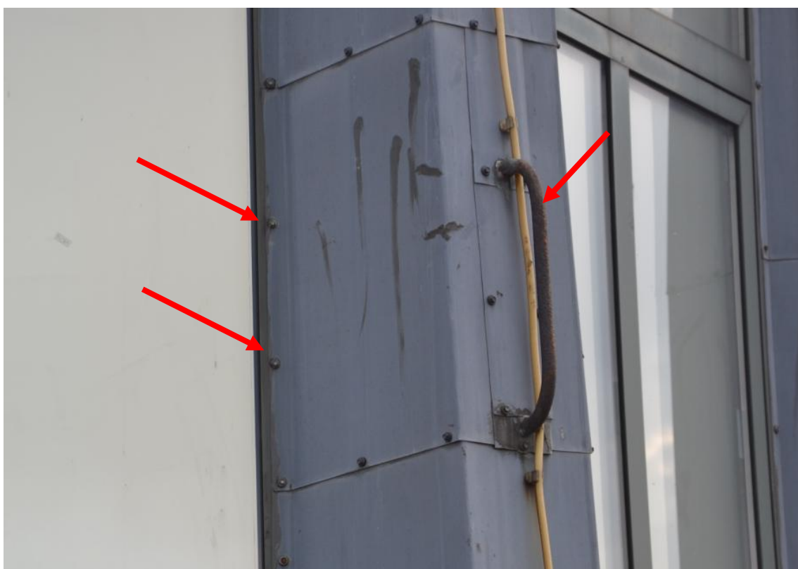
Foto. 65. Korozja ucha asekuracyjnego; łączniki mechaniczne przykręcone do ramy okiennej [1.3].
