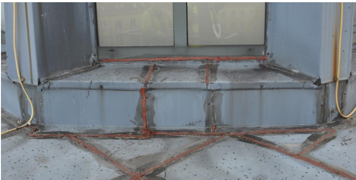
Foto. 61. Liczne uszczelnienia uszczelniaczem dekarskim, silikonem itp. na gzymsie wieżyczki oraz w obrębie parapetu [1.3].
