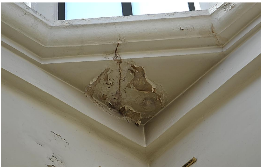
Foto. 27. Spękanie gzymsu, zacieki, odspojenia farby/gładzi [1.3].
