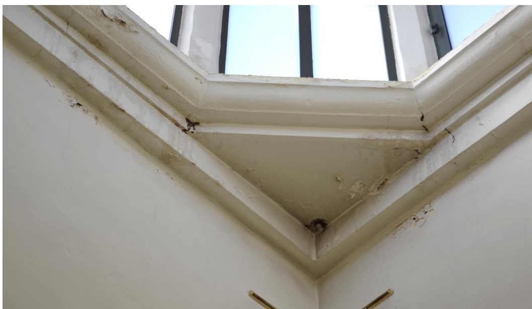
Foto. 20. Zagrzybenie, zacieki, odspojenia farby na dolnej powierzchni gzymsu [1.3].
