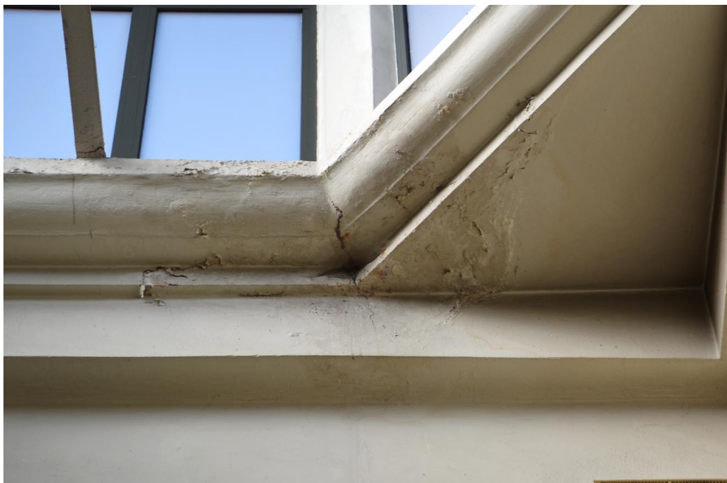
Foto. 28. Spękanie gzymsu, zacieki, odspojenia farby/gładzi [1.3].
