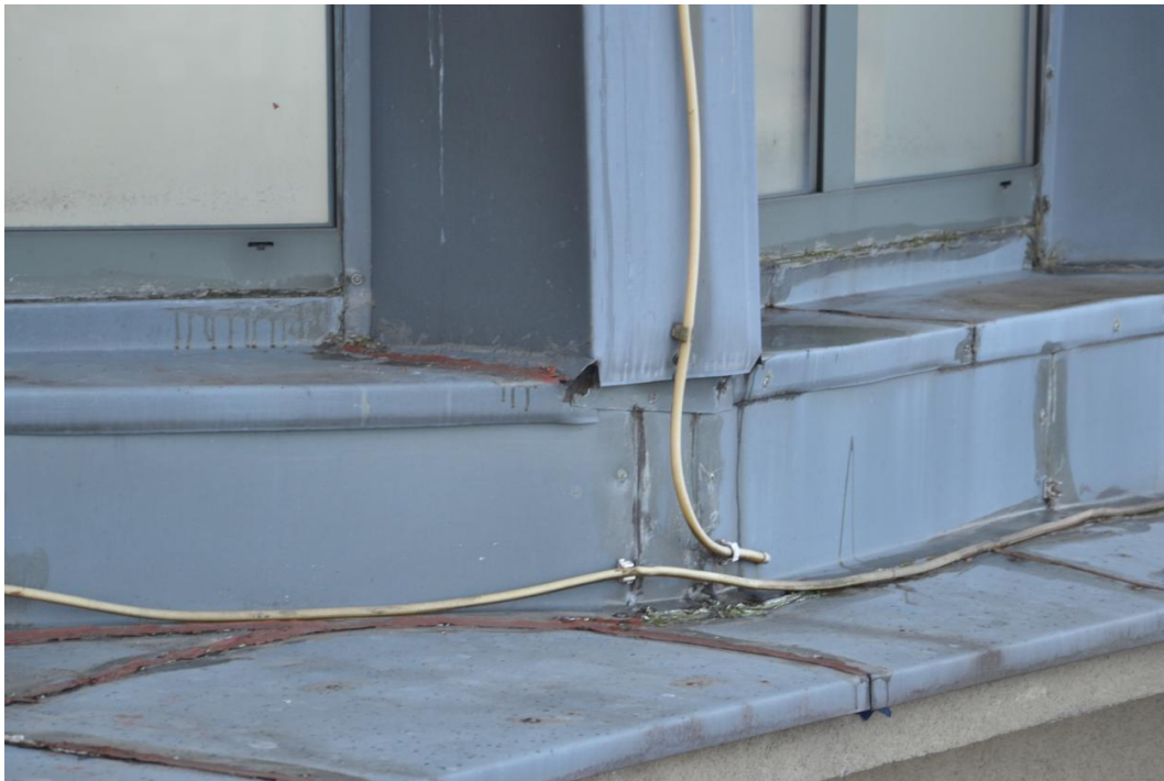
Foto. 48. Liczne uszczelniani styków z użyciem różnych materiałów, nieszczelności obróbek blacharskich [1.3].
