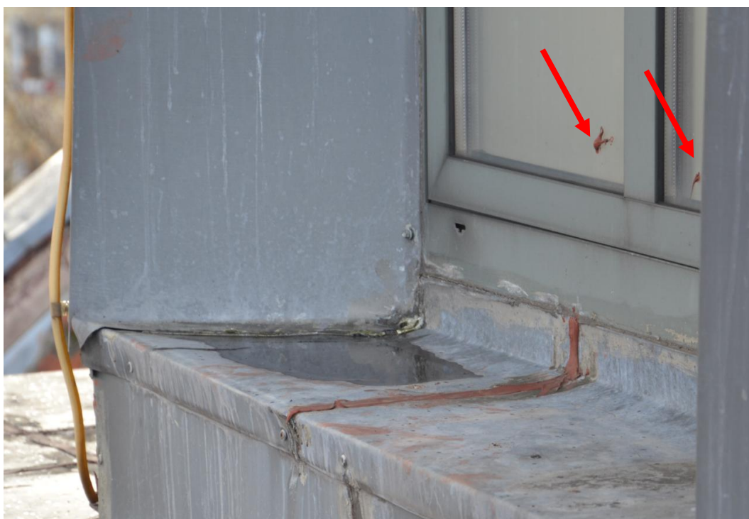
Foto. 47. Woda stojąca w niecce na parapecie; resztki uszczelnacza na szybach [1.3].
