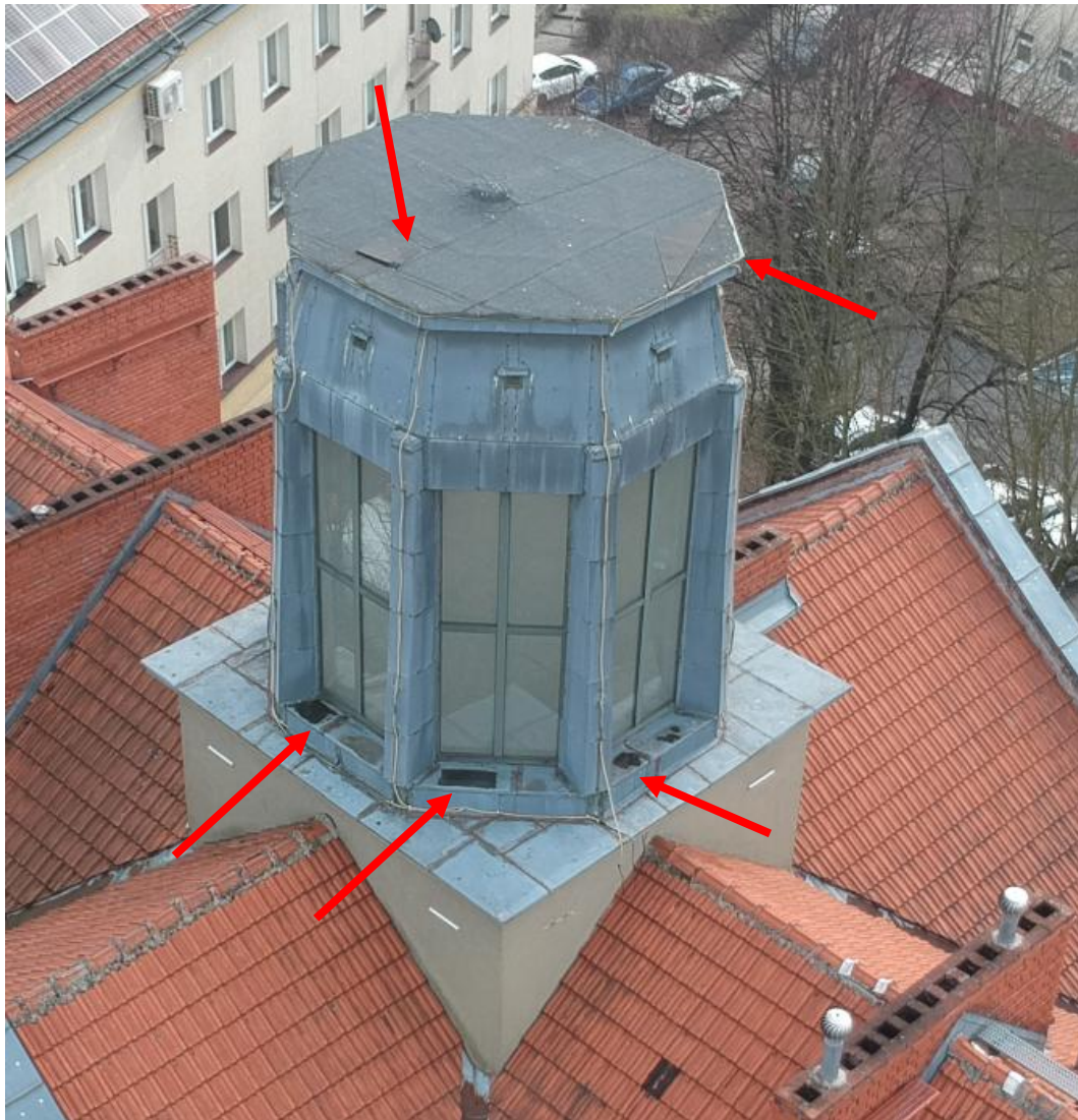
Foto. 44. Zerwane fragmenty papy; zastoiny wody na parapetach [1.3].
