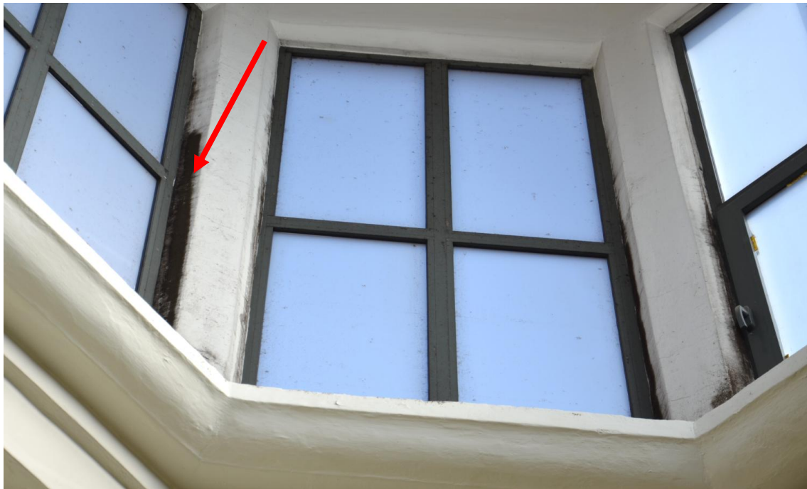
Foto. 9. Rozwój pleśni (zagrzybienia) na słupach oraz oknach [1.3].
