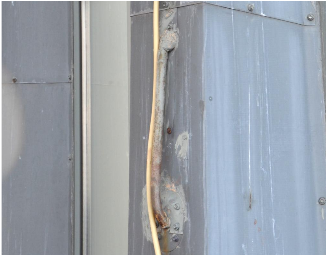
Foto. 52. Naloty korozyjne na uchwycie asekuracyjnym [1.3].
