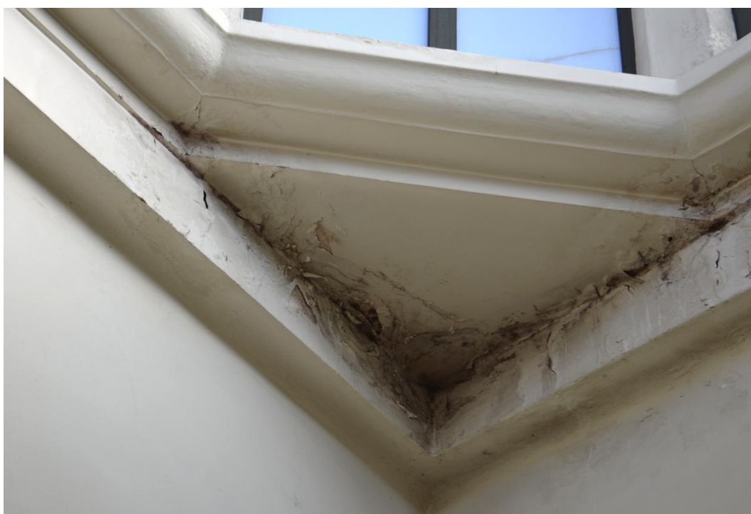
Foto. 39. Zacieki, odspojenia tynku i farby [1.3].
