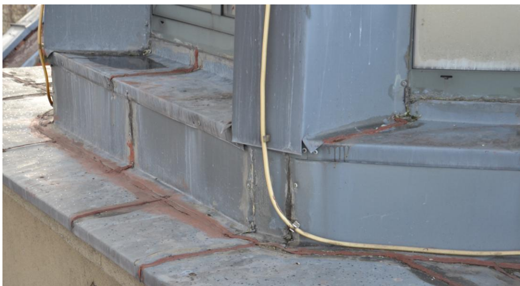
Foto. 46. Liczne uszczelnienia styków przy użyciu różnych materiałów, przeciwnie spadki i zastoiny wody na obróbkach blacharskich [1.3].
