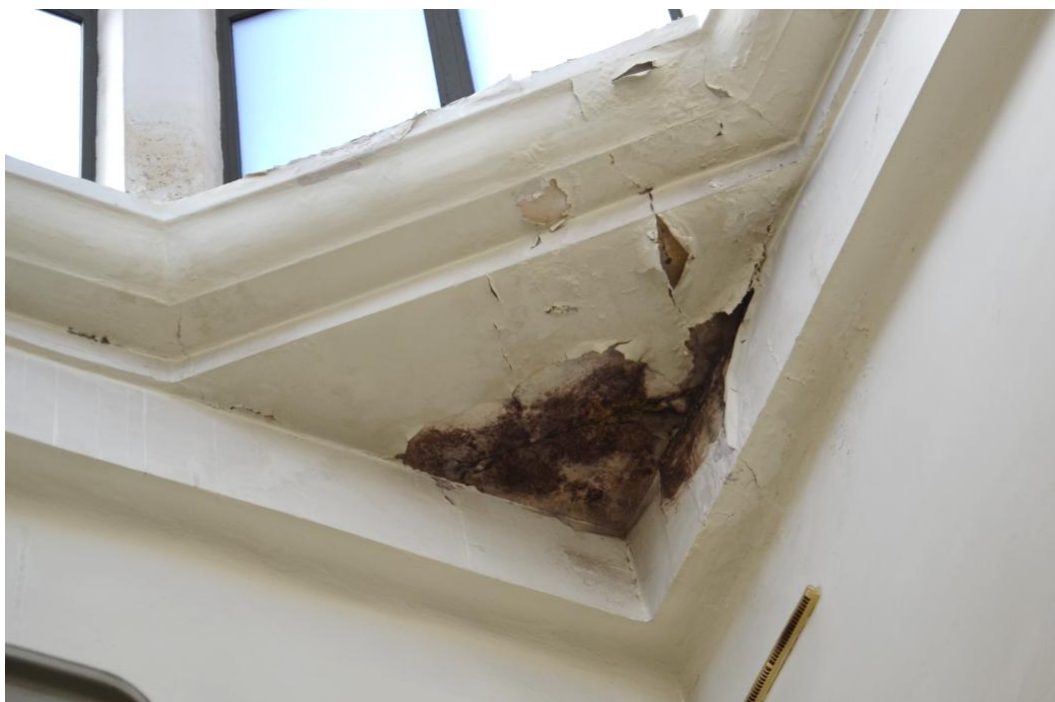
Foto. 36. Rozwój pleśni na spodzie gzymsu; odspojenia tynku i farby [1.3].
