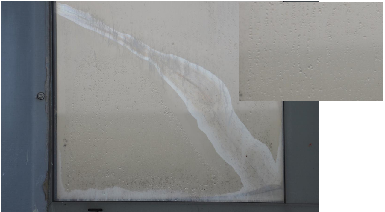
Foto. 53. Pęknięta szyba; widoczne skropliny we wkładzie szybowym [1.3].
