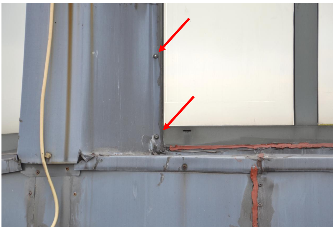
Foto. 63. Łączniki mechaniczne przykręcone do ramy okiennej [1.3].
