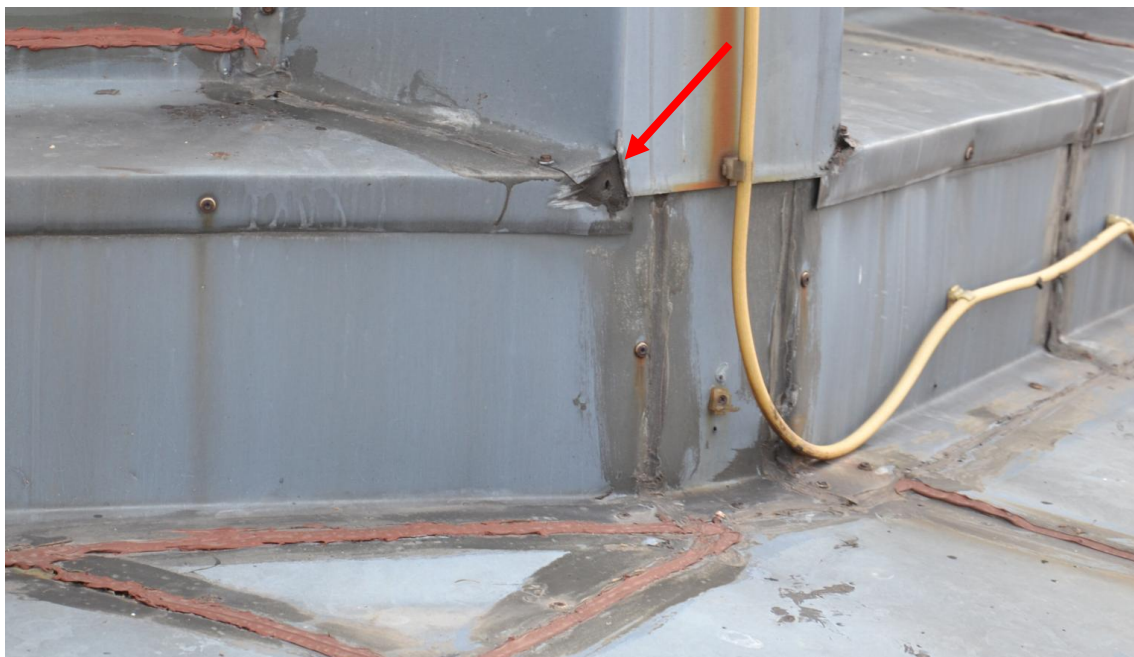
Foto. 64. Perforacja wykonanego uszczelniania z uwagi na zbyt dużą powierzchnię wypełnianej szczeliny [1.3].
