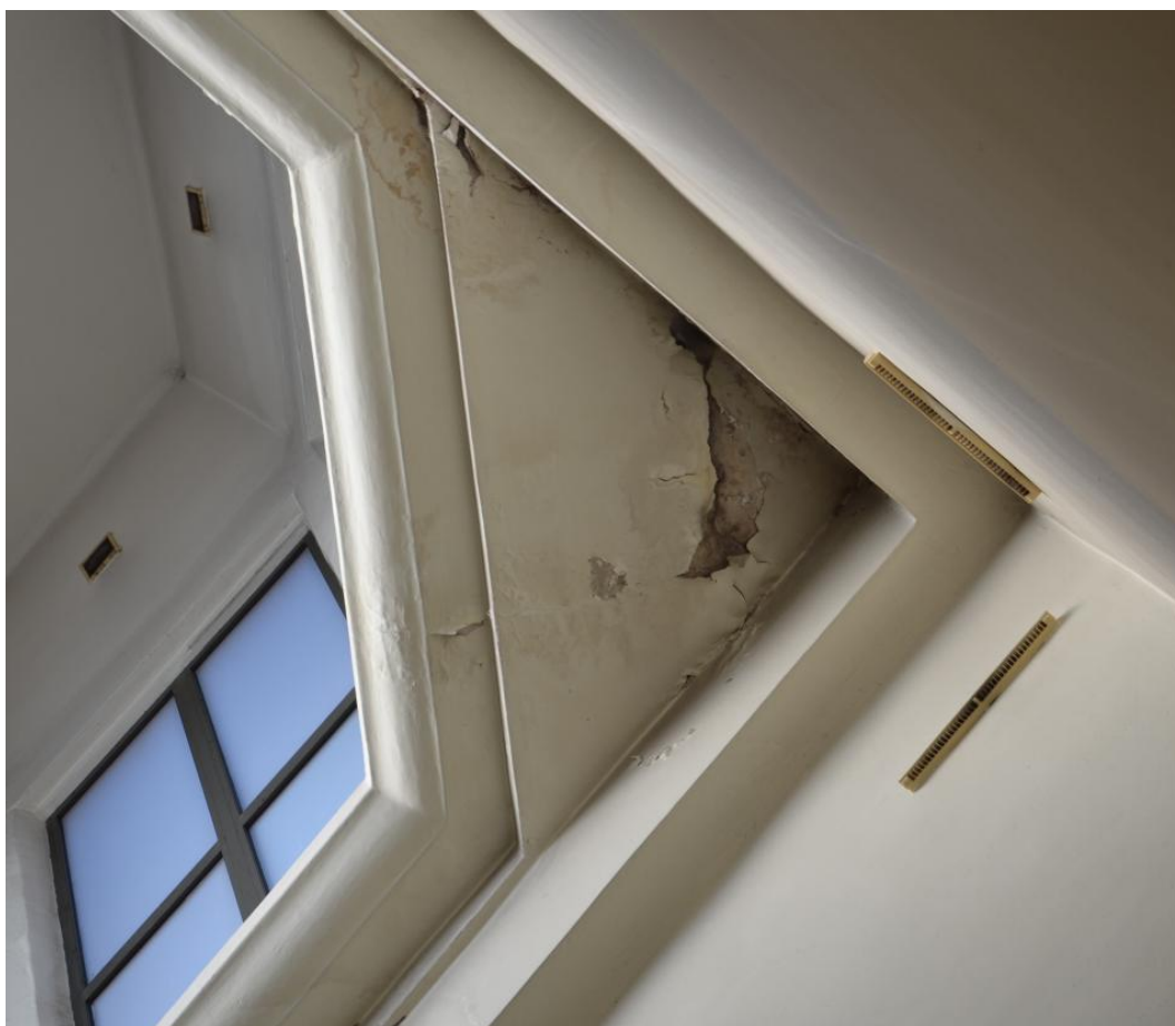
Foto. 38. Zacieki, odspojenia tynku i farby [1.3].
