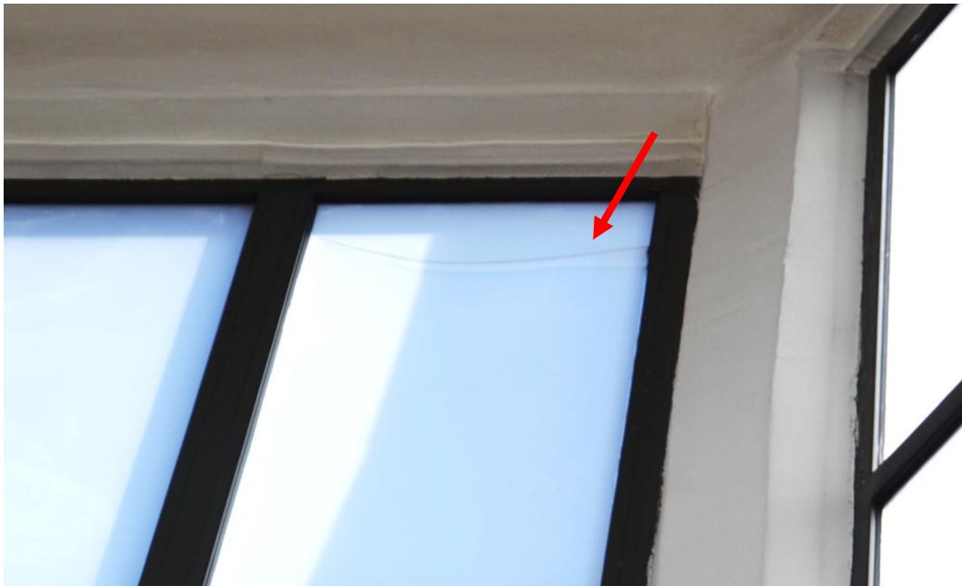
Foto. 23. Pęknięta szyba w górnej kwaterze jednego z okien [1.3].
