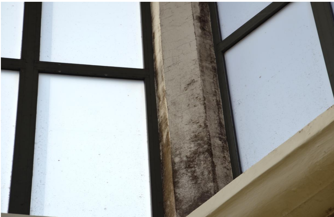
Foto. 14. Rozwój pleśni (zagrzybienia) na słupach oraz oknach [1.3].
