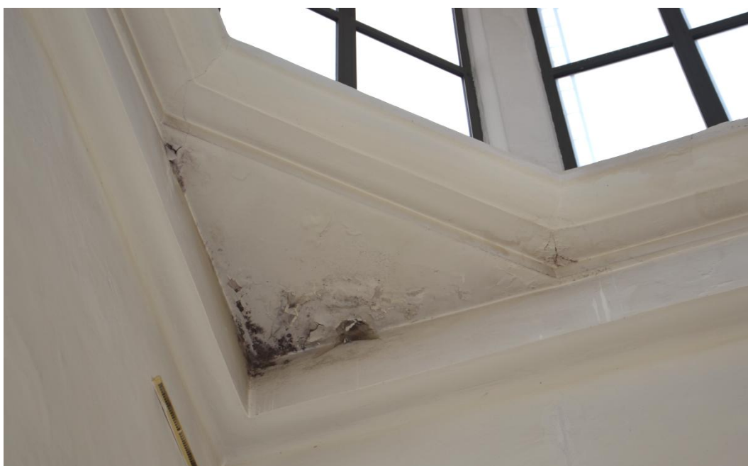
Foto. 37. Rozwój pleśni na spodzie gzymsu; odspojenia tynku i farby [1.3].
