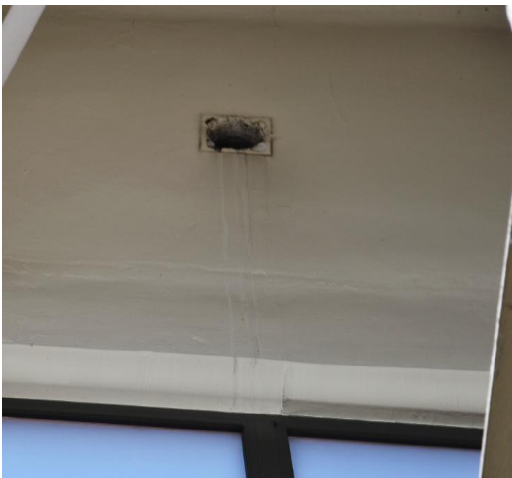
Foto. 31. Zacieki pod otworem wentylacyjnym; brak kratki wentylacyjnej [1.3].
