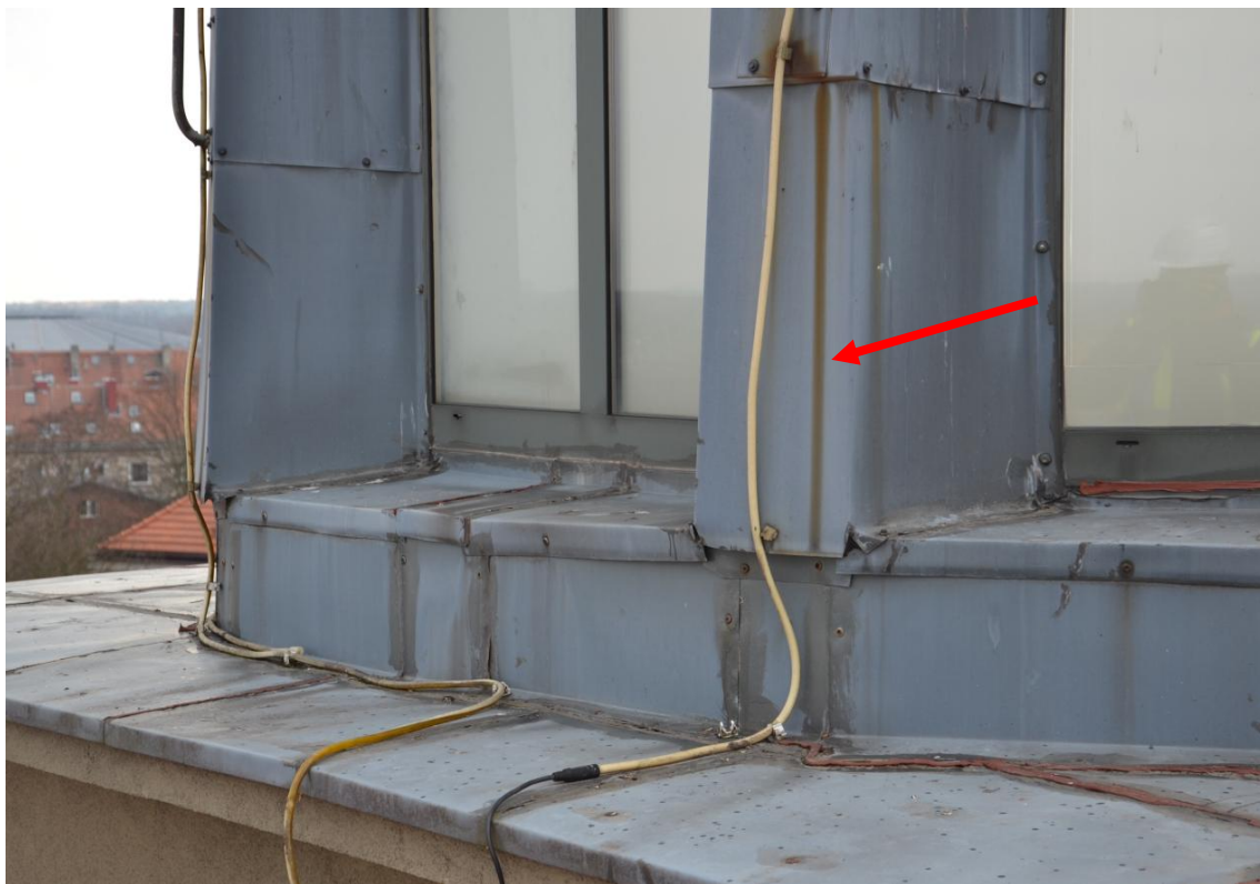
Foto. 68. Zacieki korozyjne na powierzchni blachy [1.3].
