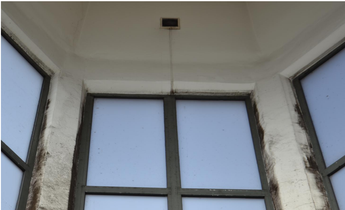
Foto. 13. Rozwój pleśni (zagrzybienia) na słupach oraz oknach; zacieki z kratki wentylacyjnej [1.3].
