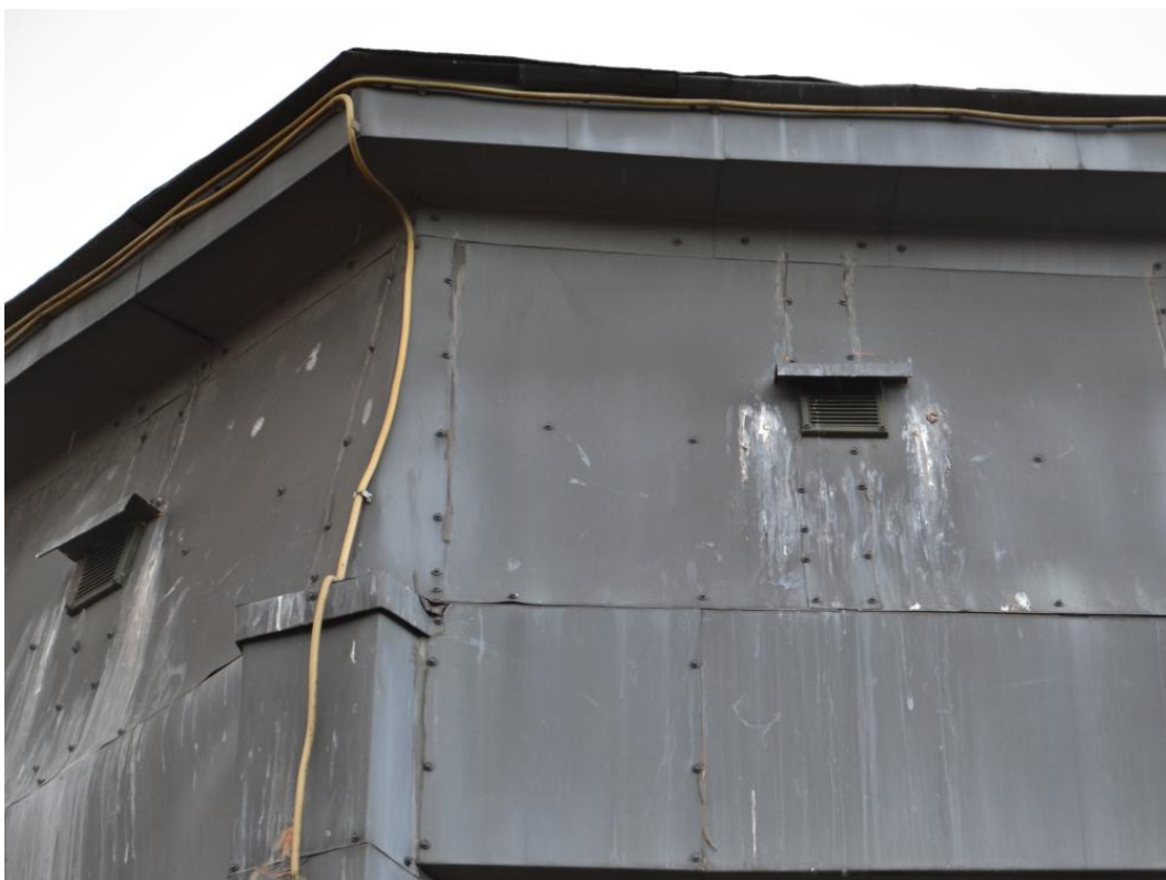
Foto. 51. Zabrudzenia nieczystościami ptasimi odchodami przy kratkach wentylacyjnych [1.3].
