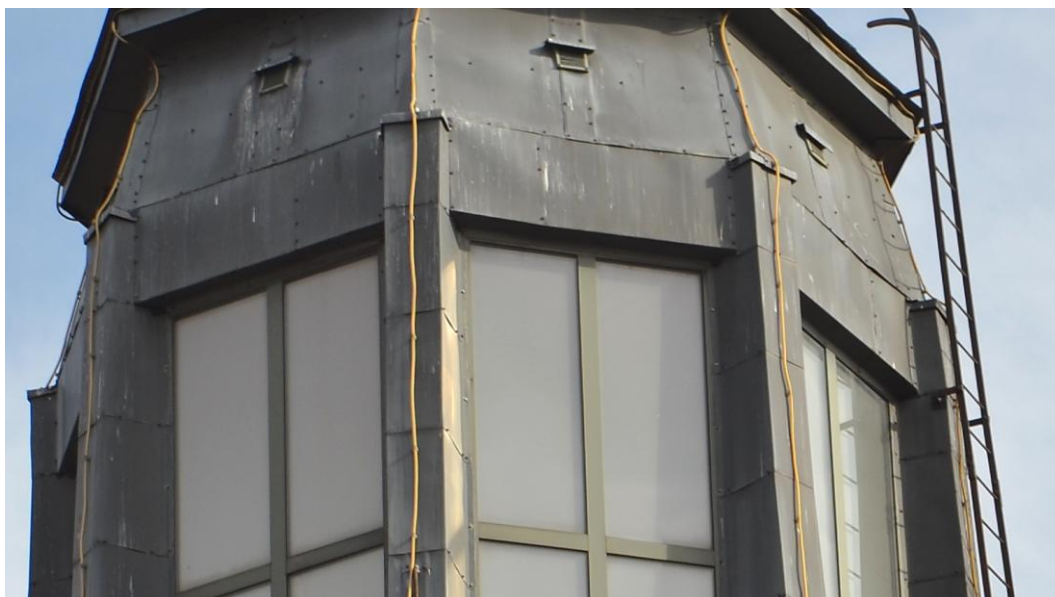
Foto. 18. Odształcenia blachy; blacha mocowana mechanicznie do ram okiennych (!); korozja drabiny [1.3].
