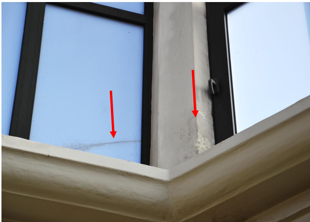
Foto. 40. Pęknięta szyba w jednym z okien; ślady zawilgocenia na filarku międzyokiennym [1.3].
