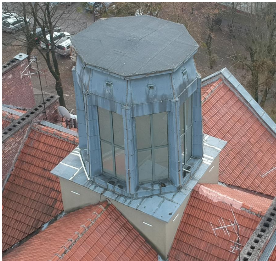
Foto. 33. Zastoiny wody na parapetach; uszczelniania styków przy użyciu taśm [1.3].
