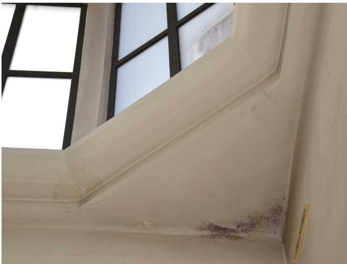
Foto. 57. Rozwój zagrzybienia, zacieki na gzymsie [1.3].
